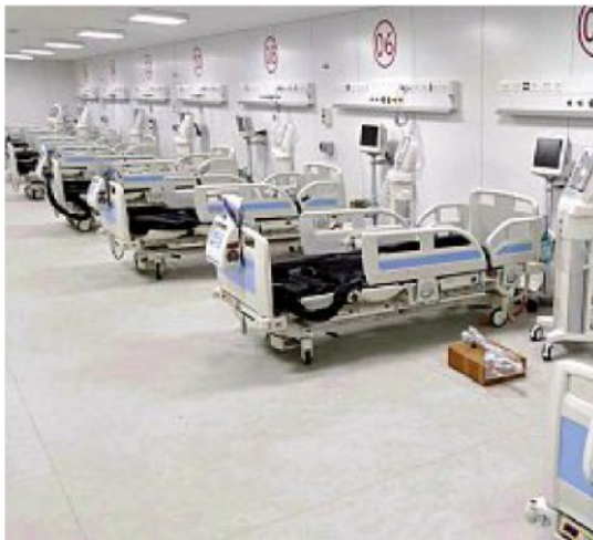
La struttura e il sopralluogo
